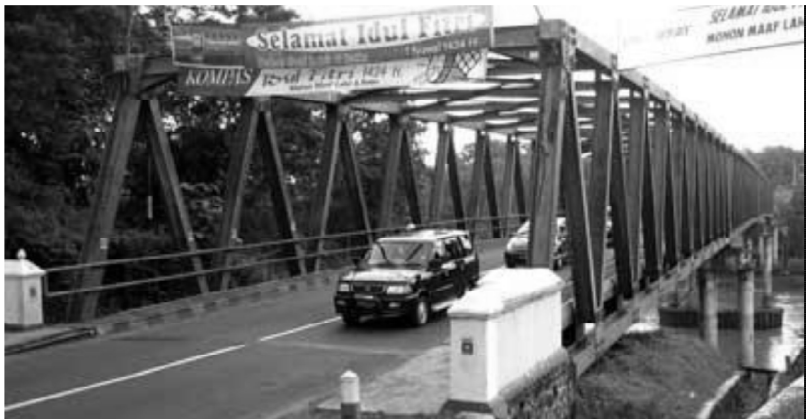
Gambar 2. Jembatan Progo Setelah Ada Pembangunan Sumber: http://zeniad.wordpress.com/2009/01/27/antai-jembatan/
